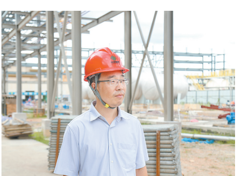
图为刘建刚在项目建设工地。
